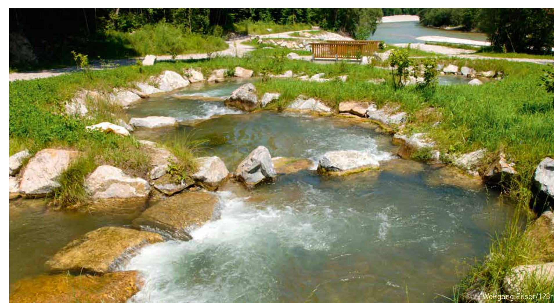
Fischtreppen ermöglichen es Fischen und anderen Wasserbewohnern, die Turbinen der Wasserkraftwerke unbeschadet zu überwinden.
